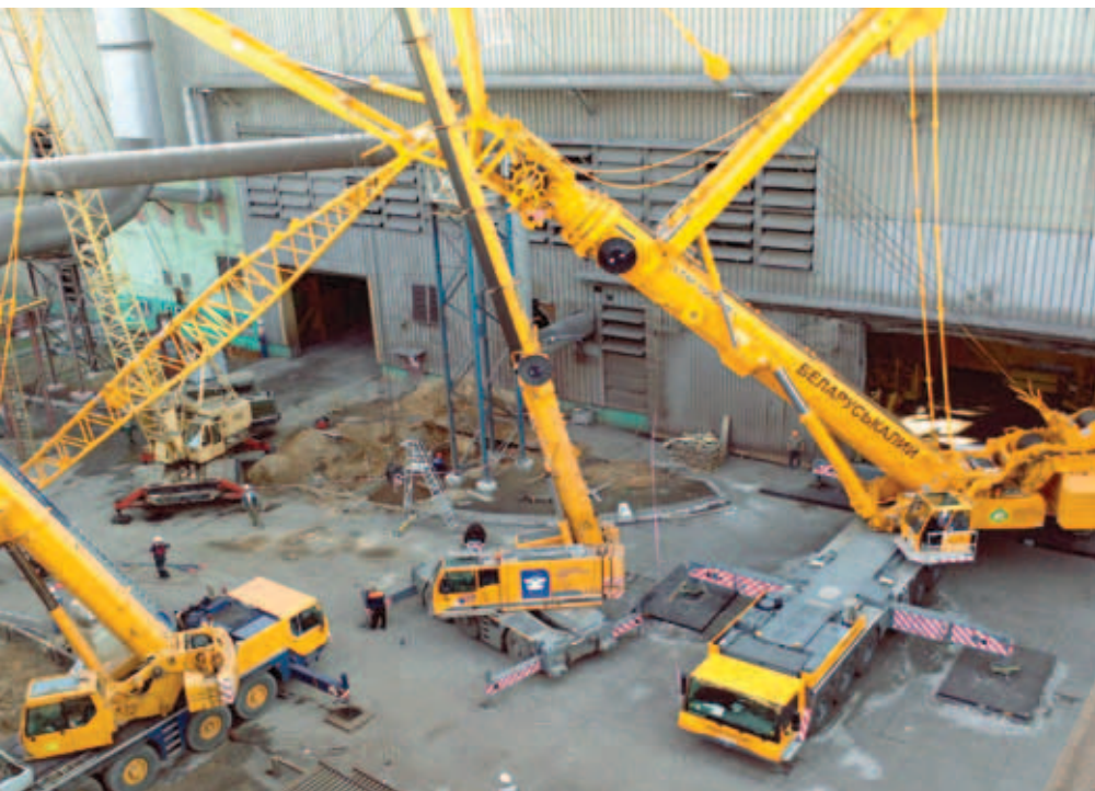
Реконструкция пылегазоулавливающей установки №1 позволила сделать процесс выплавки стали более экологичным
